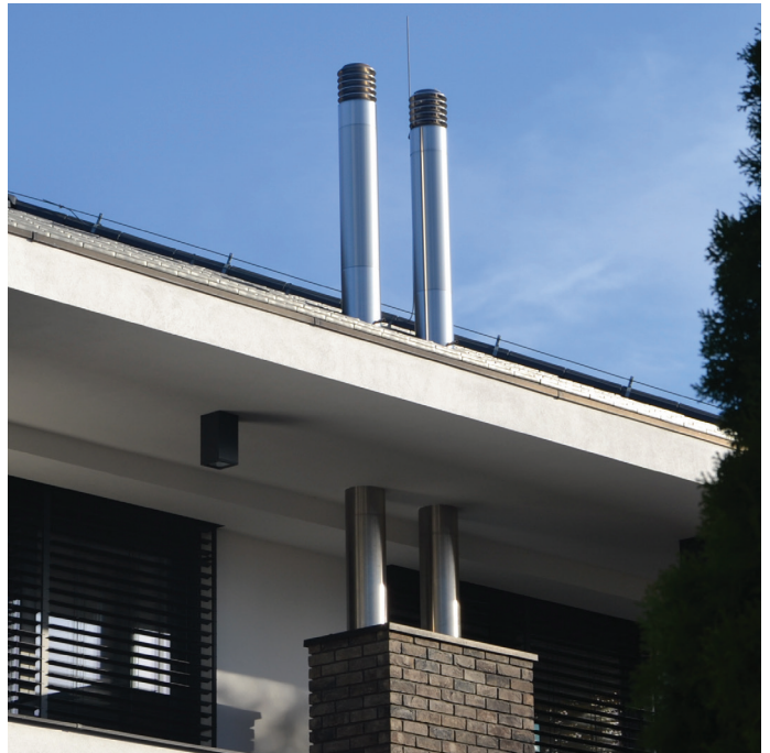
Izolirani segmentni dimnjak DW-VISION u kombinaciji sa kaminom na drva.
