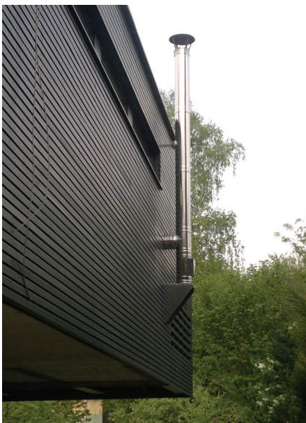
Izolirani segmentni dimnjak DW-FU montiran na pročelju zgrade.
