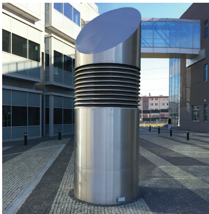
Ventilacijski toranj napravljen od brušenog nehrđajućeg čelika u Jagiellonian Centru za inovacije u Krakovu.
