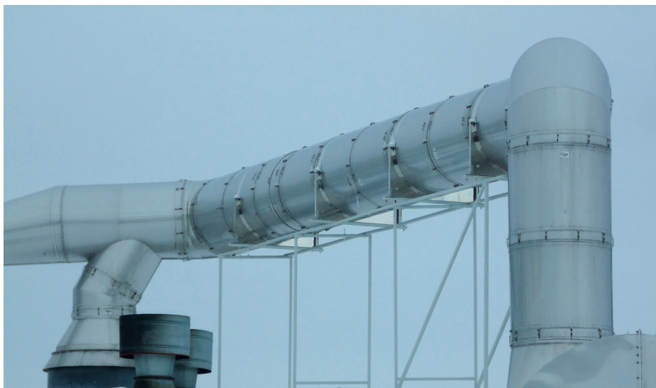
Postrojenje za rekuperaciju topline s protustrujnim izmjenjivačem topline od nehrđajućeg čelika.
